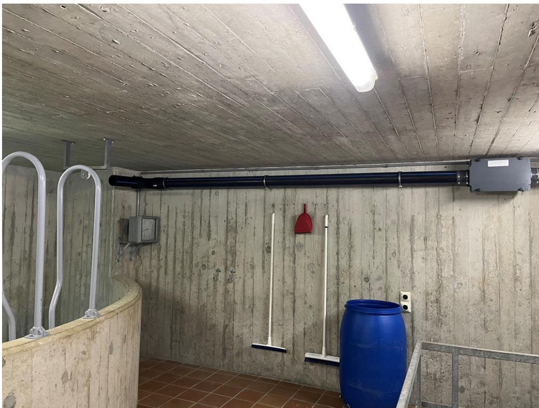
Figura 5: condotta di aerazione esistente da riprendere
