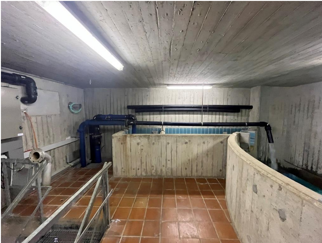
Figura 2: situazione generale P1 locale tecnico serbatoio Segiöö 1 300
