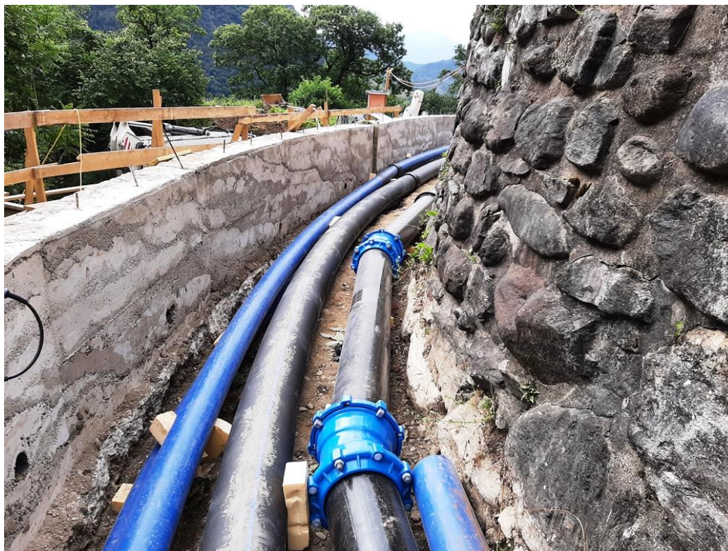
Figura 1: condotte predisposte in corrispondenza del nuovo sentiero
