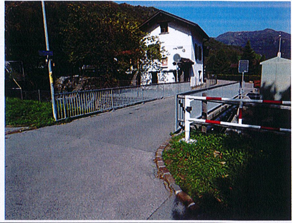
Ponte SE vista generale
