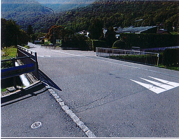
Ponte SI vista generale
